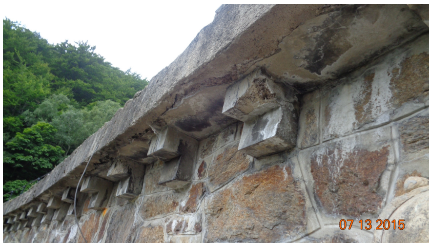
Současný stav betonových krakorců pod korunou hráze
